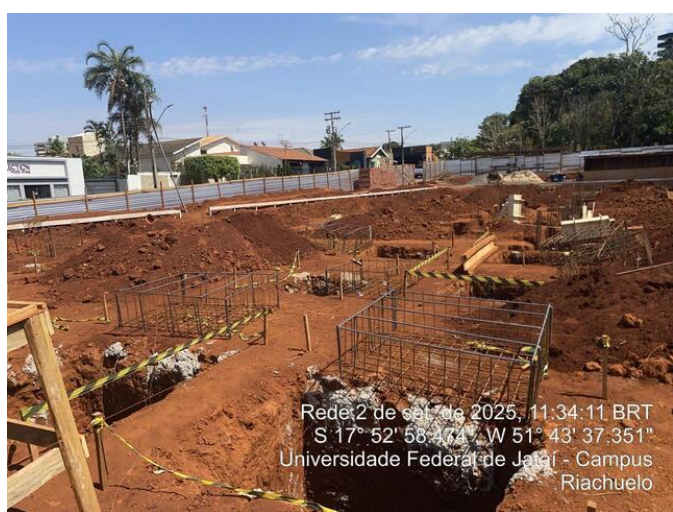
Armadura da sapata
