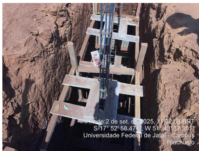
Sapata sem concreto
