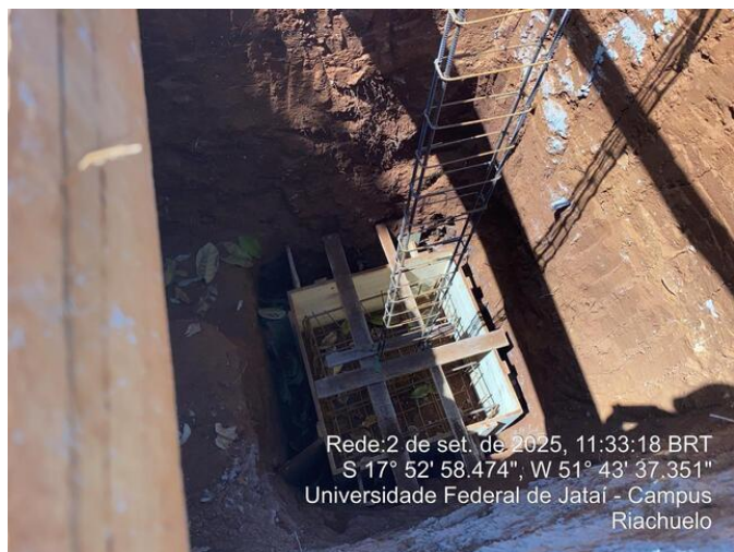
Sapata sem concreto
