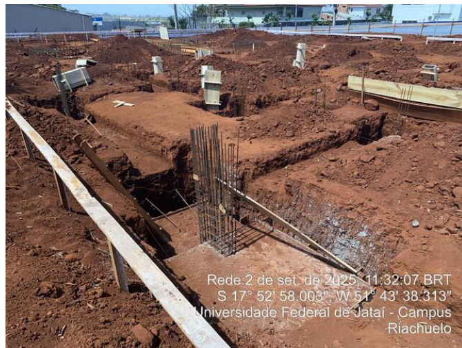
Sapata sem concreto
