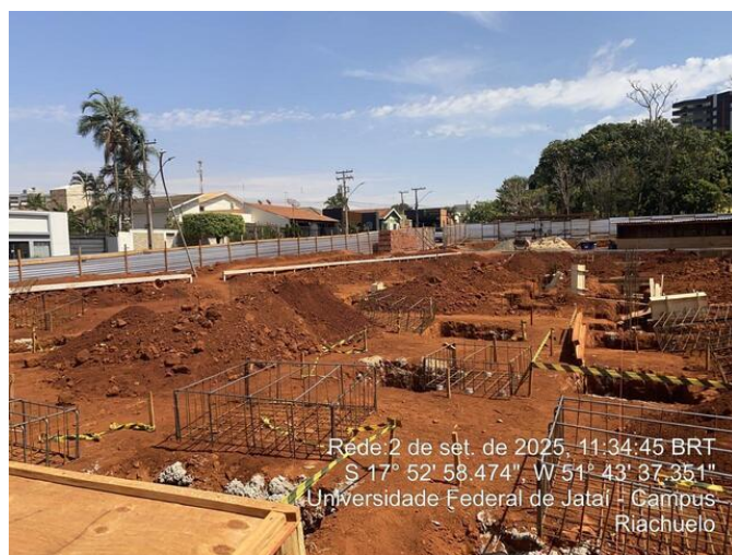
Armadura da sapata
