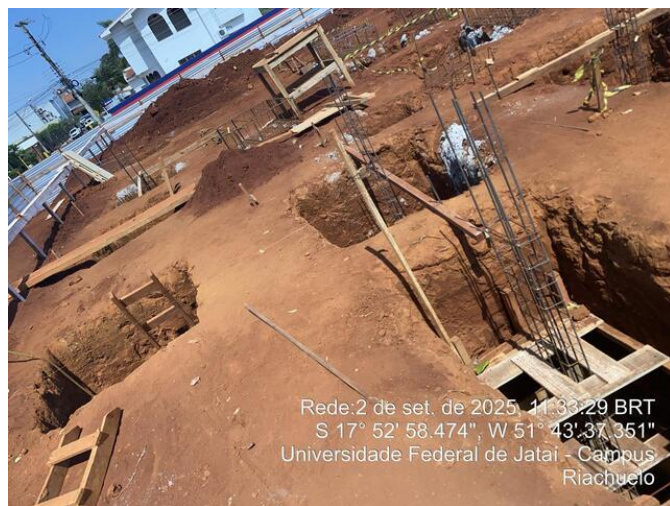
Sapata sem concreto
