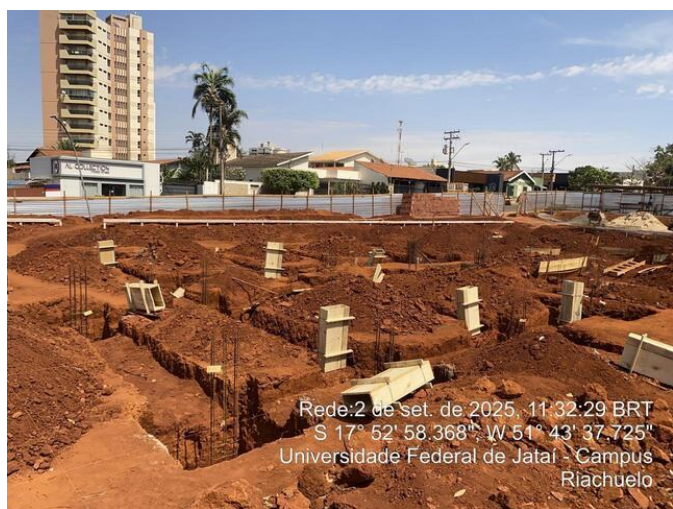
Sapata sem concreto
