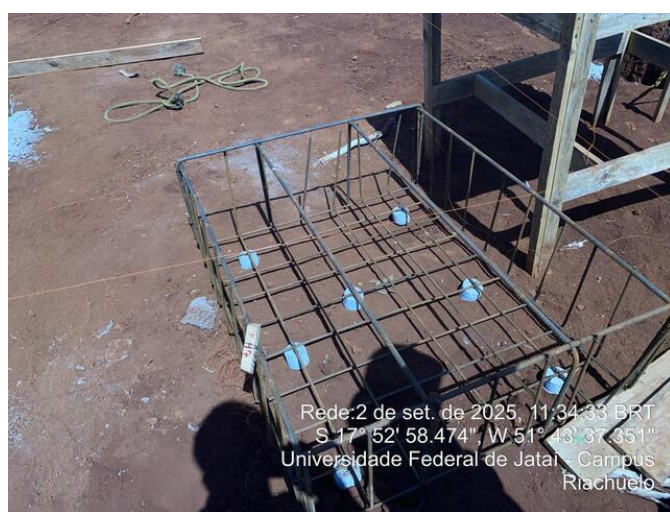
Armadura da sapata
