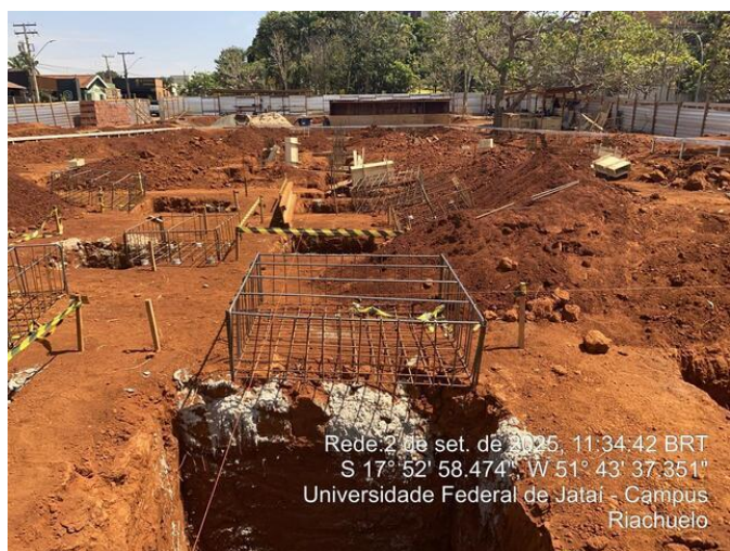
Armadura da sapata
