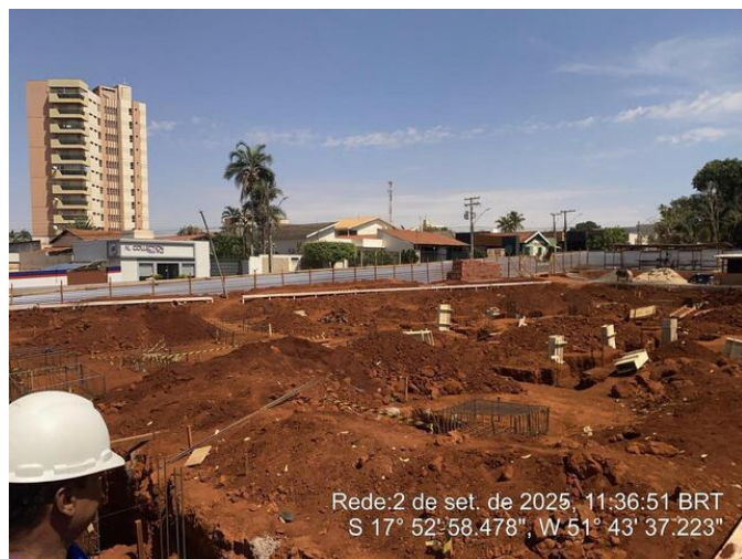
Armadura da sapata
